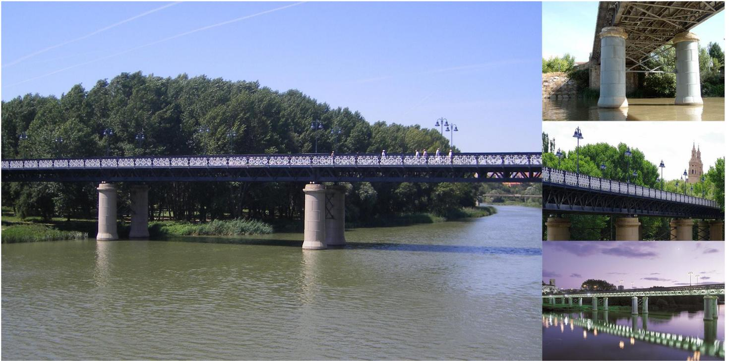
El puente se ubica sobre el río Ebro en prolongación con la calle Sagasta. Se trata de un puente recto metálico con once vanos y 330 metros de longitud total. Los estribos, tanto de la margen derecha, como de la izquierda son de fábrica de sillería de arenisca.
